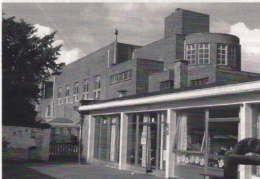
Zuid- en oostgevel van het Van Reethgebouw, gezien vanaf de tuinzijde.
